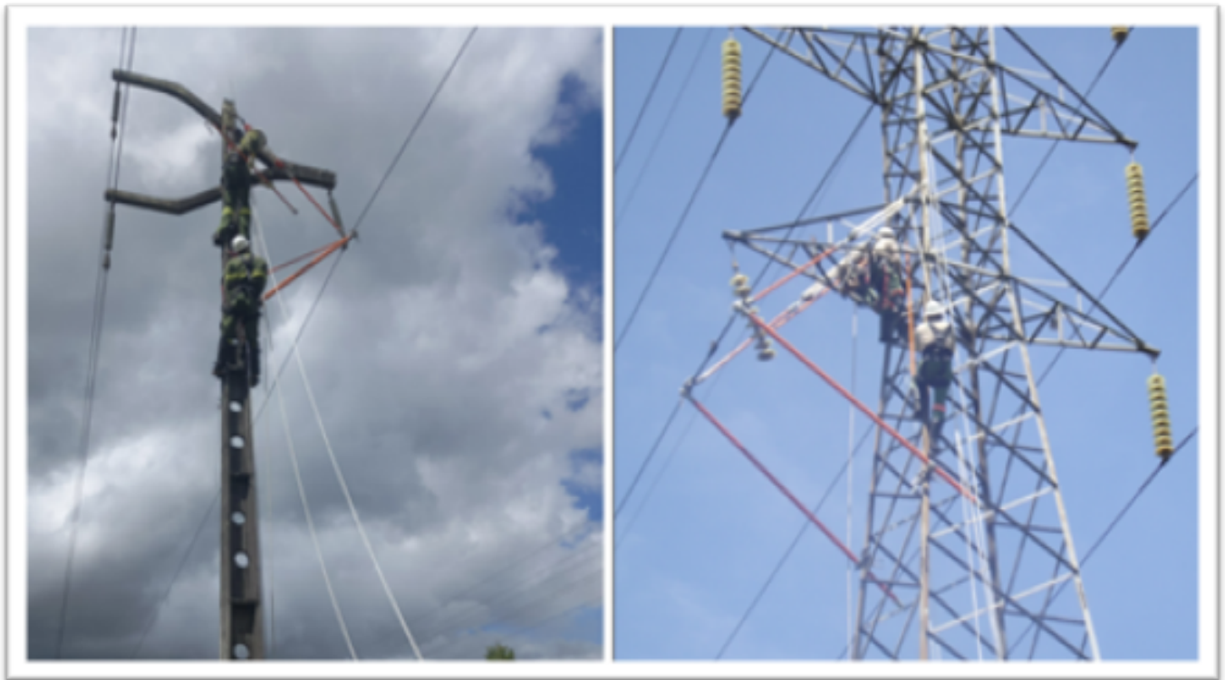
Imagem 2: Atividade de linha viva à distância em linha de subtransmissão
