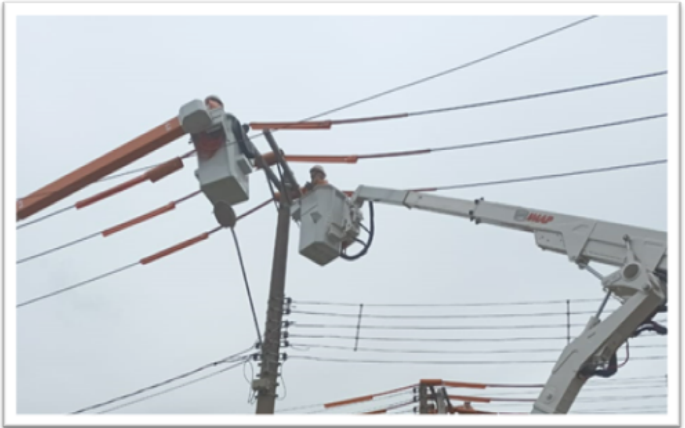
Imagem 1: Atividade de linha viva ao contato em média tensão
