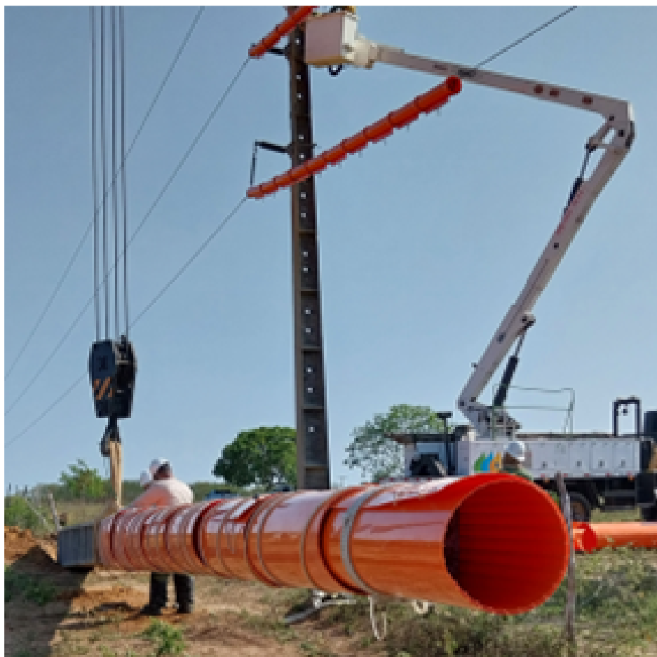
Imagem 8: Aplicação de coberturas isolantes para postes
