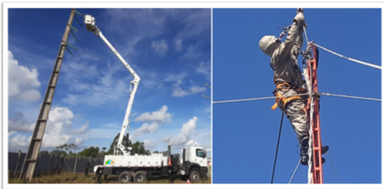
Imagem 3: - Atividade de linha viva à distância em alta tensão
