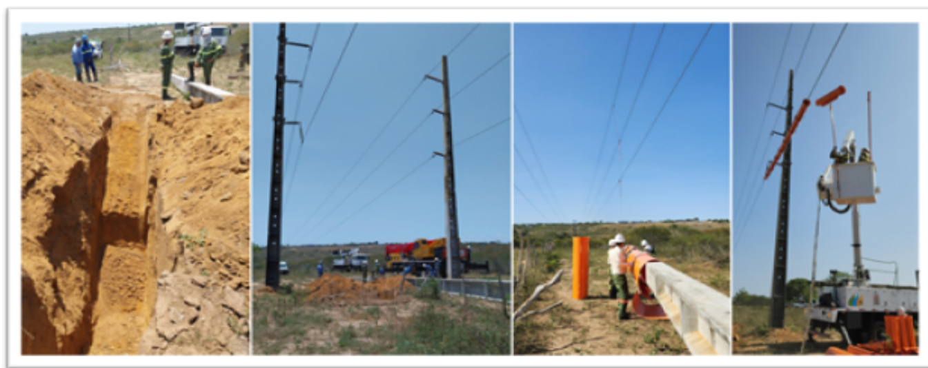
Imagem 7: Aplicação de cobertura isolantes na LT e proteção de poste na LT Feira 3 / Serrinha
